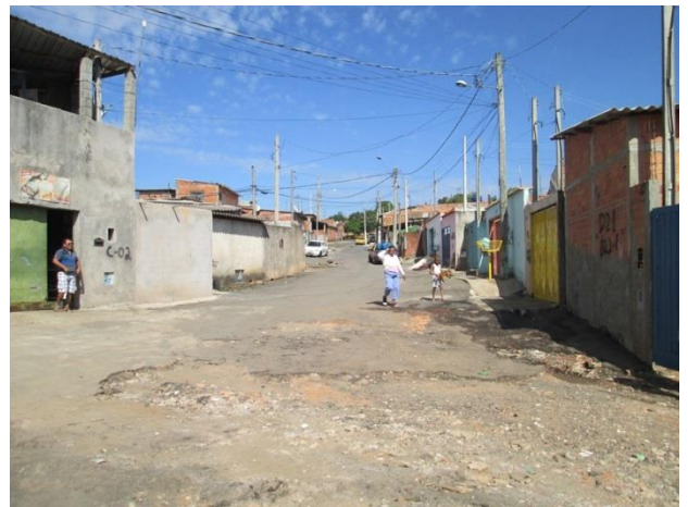
Foto 04: Detalhes da rua erodida.
