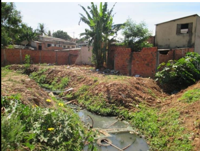
Foto 05: Drenagem superficial para escoamento na área de risco
