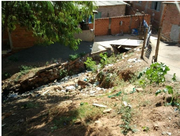
Foto 01: Vista do curso d'água e das moradias praticamente dentro do córrego.
