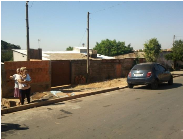
Foto 05: Vista da rua e residências em área de risco.
