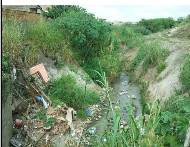
Foto 03: Vista da montante do córrego.
