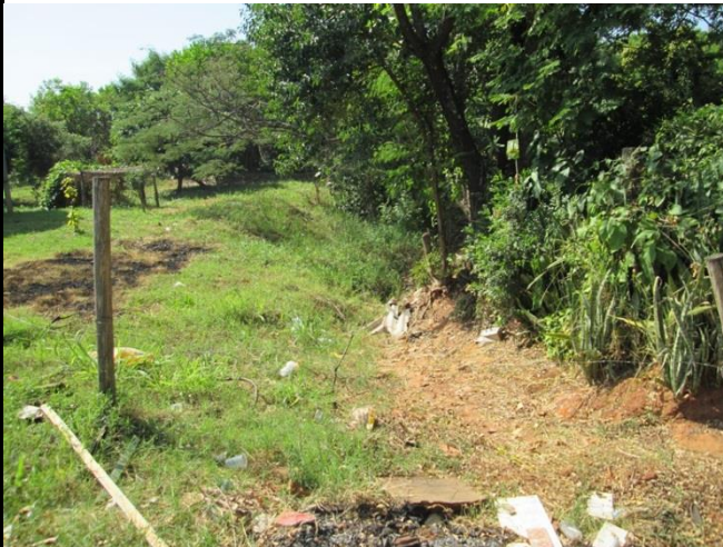
Foto 03: Pequeno canal de drenagem no terreno adjacente a Rua Salvador Lombardi Netto
