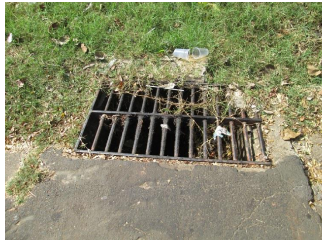
Foto 02: Drenagem na Rua Salvador Lombardi Netto.
