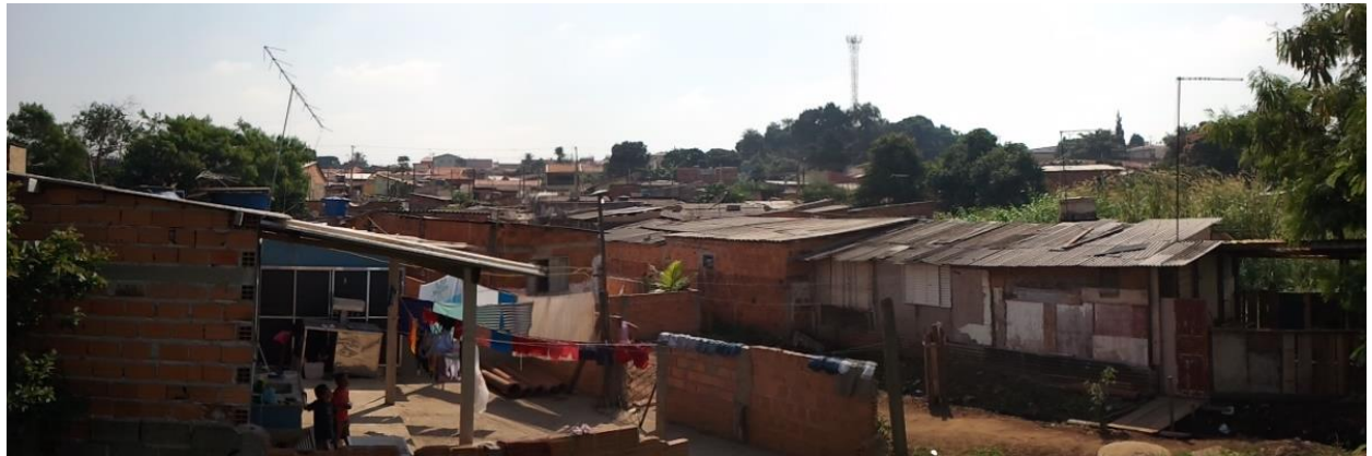
Foto 05: Panorâmica com as residências precárias na área de inundação do córrego
