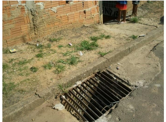
Foto 07: Detalhe da drenagem urbana
