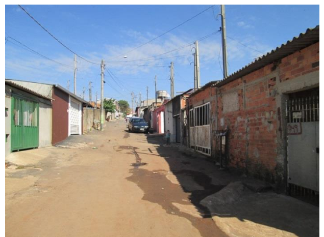
Foto 08: Vista da rua e das benfeitorias diretamente atingidas em eventos de enchente e inundação.
