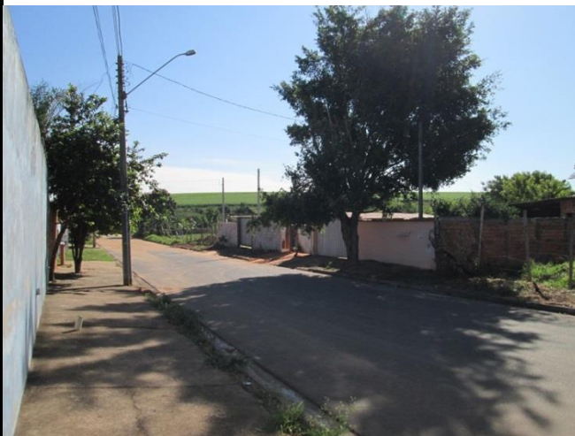
Foto 03: Vista parcial do final da Rua Claudemir Eugenio onde evidencia-se material terroso depositado no asfalto.
