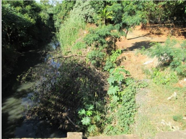
Foto 01: Jusante do Córrego Tijuco Preto, margem solapando como pode-se visualizar pela árvore que cedeu.
