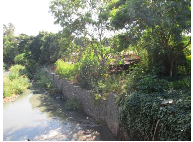
Foto 02: Vista da margem direita a jusante, contensão e benfeitorias construídas na APP do córrego.
