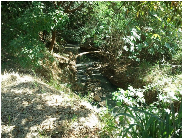
Foto 05: Córrego afluente do ribeirão, margens erodidas e em processo de solapamento.
