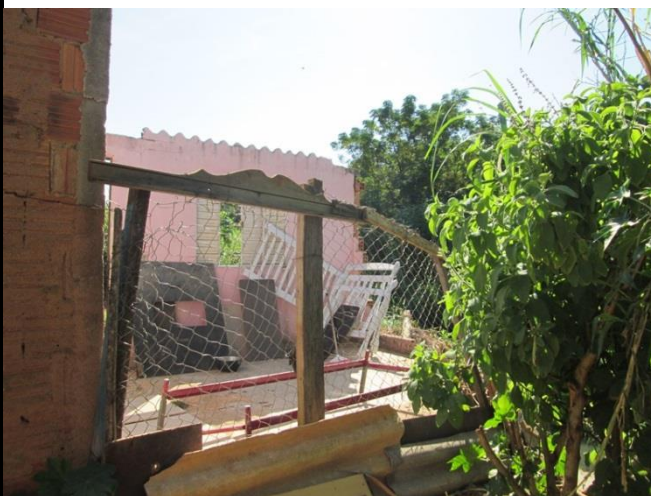
Foto 05: Vista de ruínas de benfeitoria que sedeu em eventos de inundações e provável instabilidade das margens
