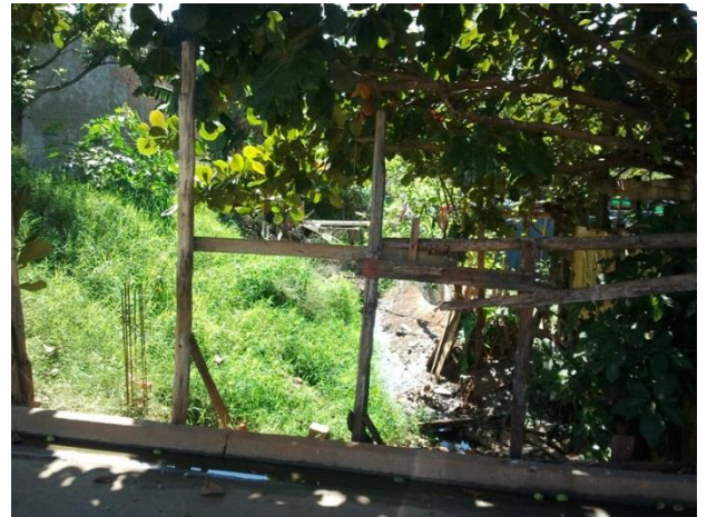
Foto 06: Trecho do canal ao fundo de terreno próximo ao córrego.
