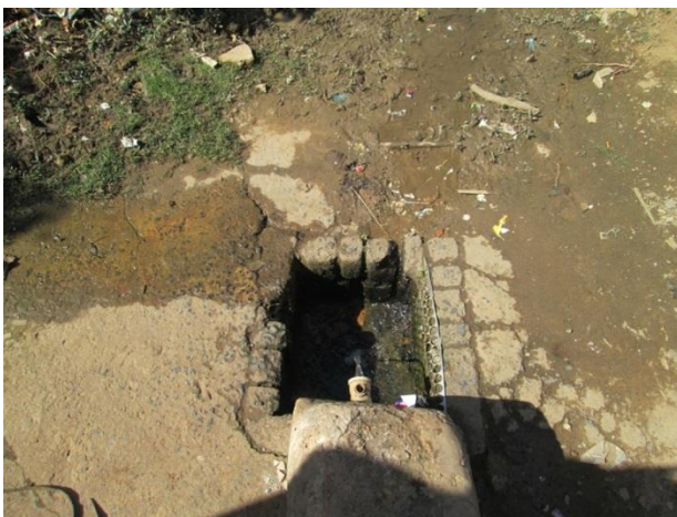
Foto 05: Detalhe da nascente canalizada onde a água é utilizada pela comunidade.
