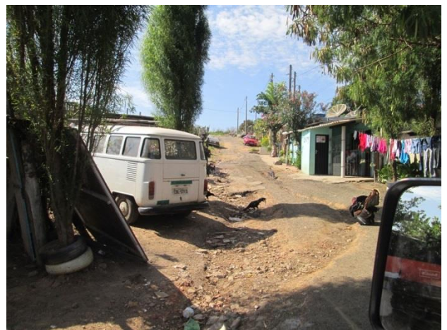
Foto 06: Erosão causada pela falta de drenagem no pé da encosta já na área da invasão
