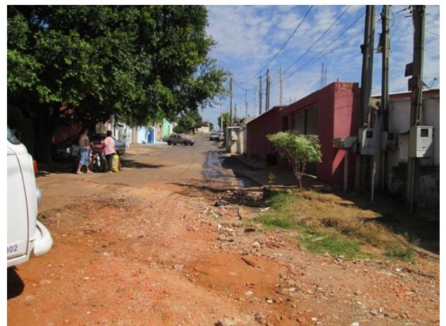
Foto 06: Detalhe dos sulcos erosivos causados por falta de drenagem urbana.
