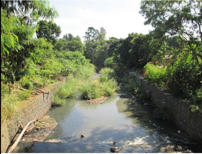
Foto 01: Jusante do Córrego Tijuco Preto, nas margens contensão e no leito assoreamento.
