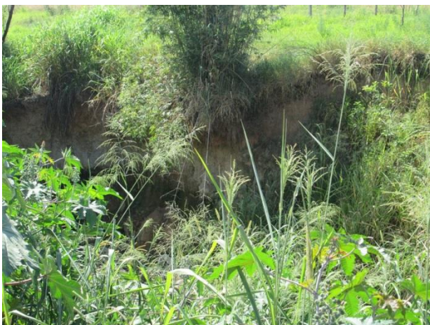
Foto 05: Erosão e solapamento das margens.
