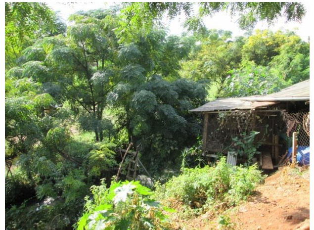
Foto 02: Vista do talude marginal do córrego e de benfeitoria.
