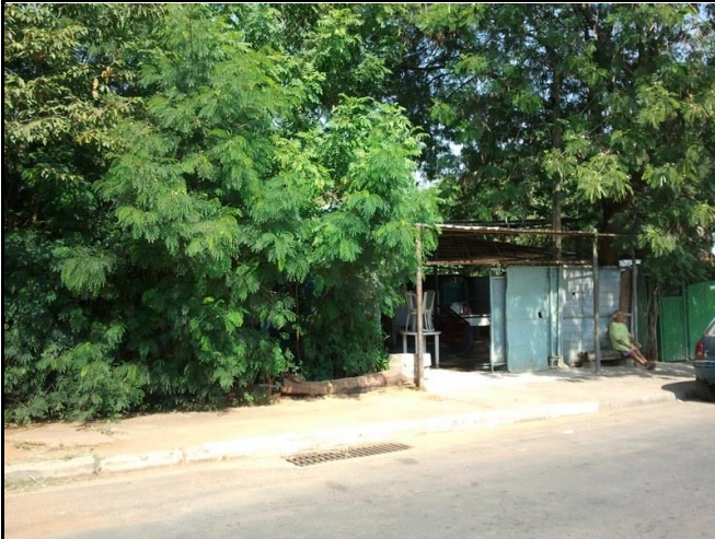
Foto 01: Vista da rua, drenagem e benfeitoria adjacente ao córrego.
