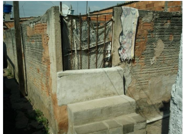
Foto 02: Vista da contenção em benfeitoria para evitar a invasão de água.
