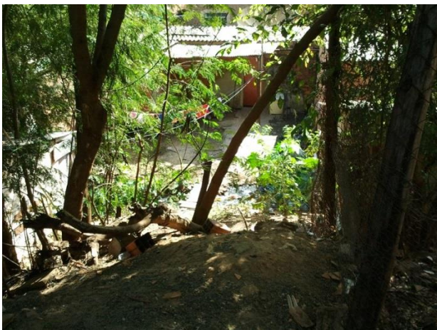
Foto 07: Vista do talude marginal e pouca vegetação na área de risco.
