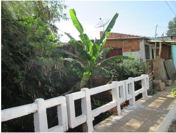
Foto 03: Benfeitoria na margem do córrego em situação de risco
