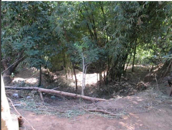
Foto 01: Vista da margem esquerda do córrego, evidenciando cicatriz de solapamento do talude marginal.
