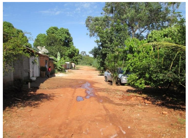
Foto 06: Detalhes do escorregamento no pé da encosta ao lado da rua.
