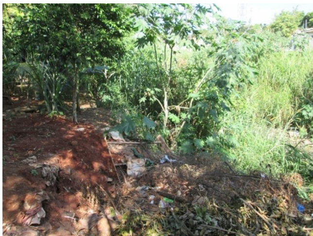
Foto 05: Vista da parte superior da encosta
