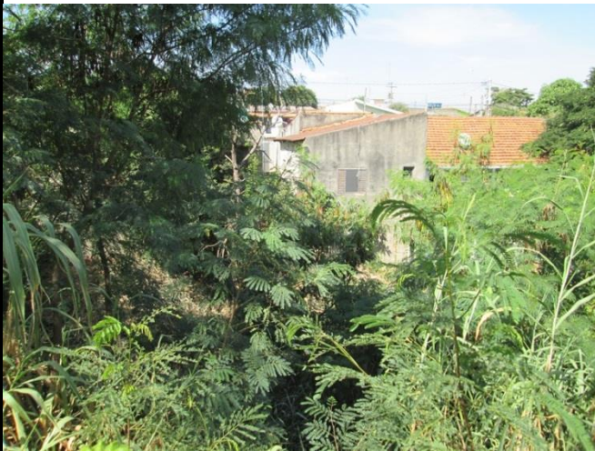
Foto 01: Vista parte superior do córrego com as residências ao fundo na margem esquerda.
