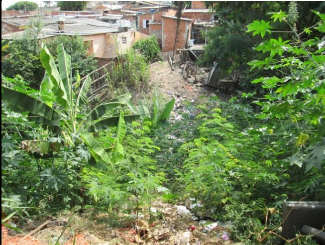
Foto 03: Vista da margem direita, residências em situação de risco.
