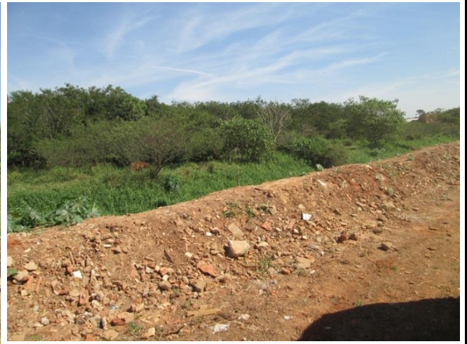
Foto 04: Detalhes do dique de contenção construído a margem do ribeirão
