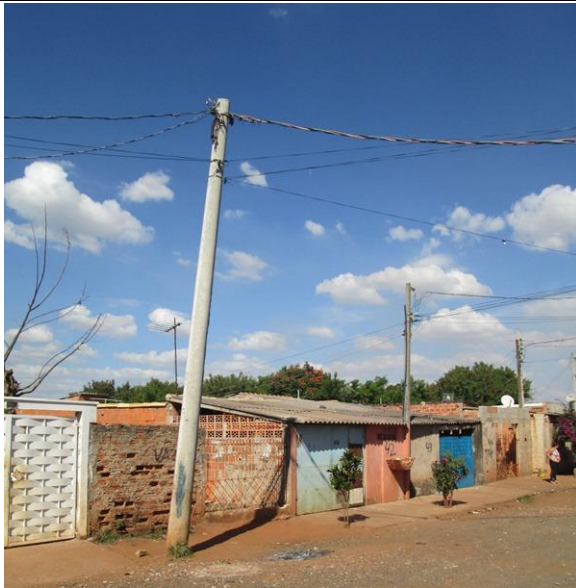
Foto 07: Vista de poste inclinado na rua.
