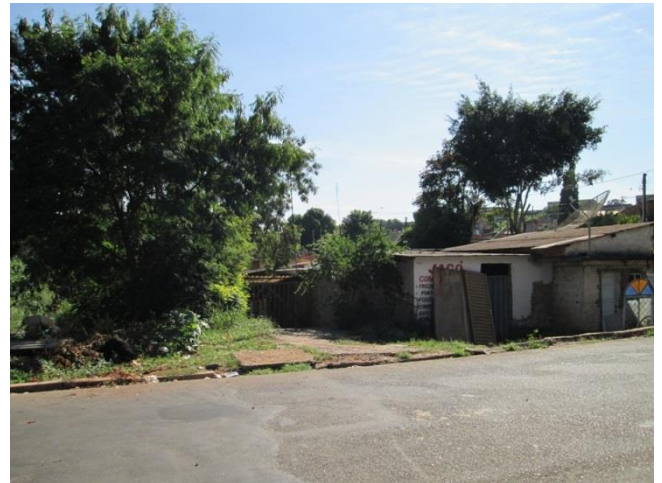
Foto 04: Detalhes das residências á margem do córrego
