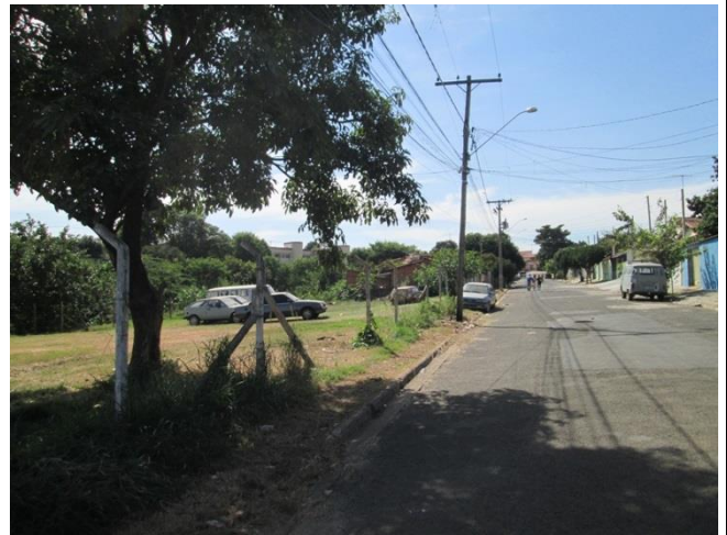
Foto 02: Rua Fernando de Noronha adjacente ao córrego.
