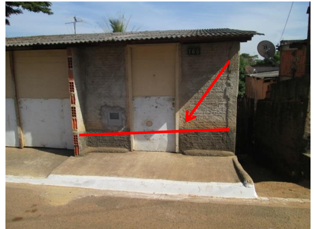
Foto 02: Marca d'água de enchentes e enxurradas na moradia.
