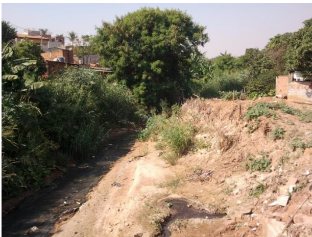
Foto 04: Detalhe do córrego assoreado e da margem erodida
