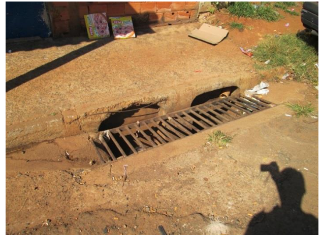
Foto 04: Detalhes da drenagem na rua.
