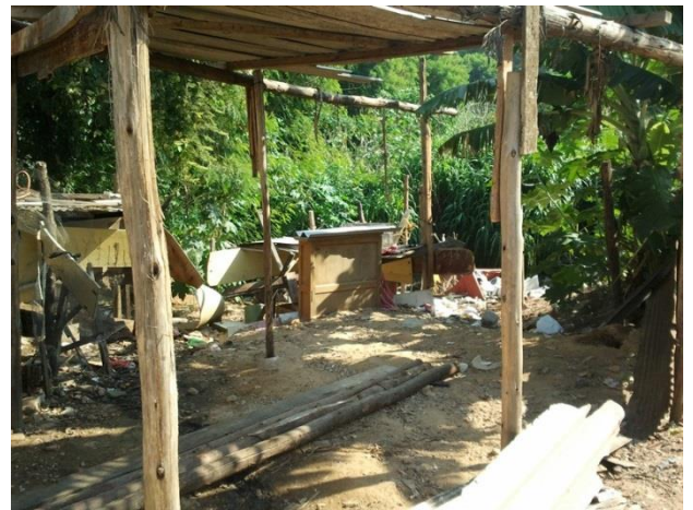
Foto 02: Vista da invasão na margem do córrego, lixo e entulho depositado em erosão.
