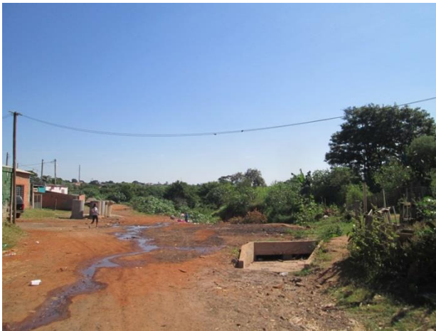
Foto 03: Vista da área e da drenagem.
