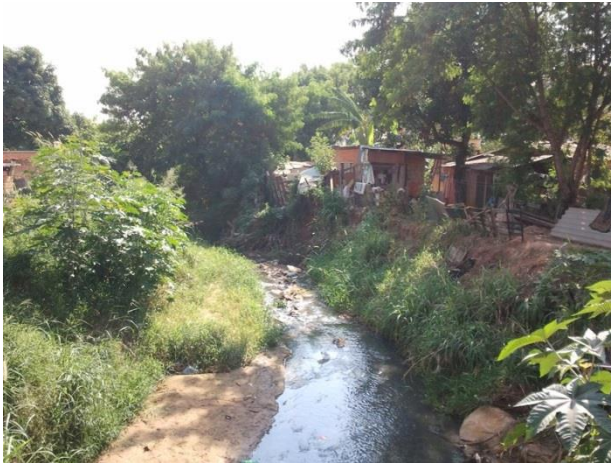
Foto 06: Vista da jusante do canal, benfeitorias na margem esquerda.
