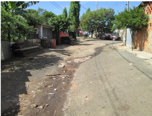
Foto 03: Sulco erosivo na parte inferior da invasão devido à falta de drenagem
