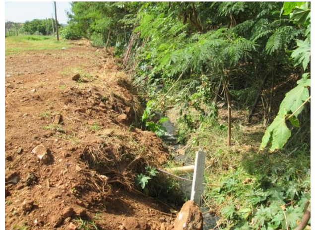
Foto 04: Detalhe da drenagem realizada pelos moradores para escoamento superficial também é utilizada como esgoto.
