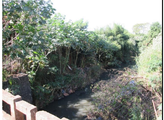
Foto 02: Margem esquerda do córrego, ao lado, muro de pedra engaiolada como contenção ao lado da ponte.
