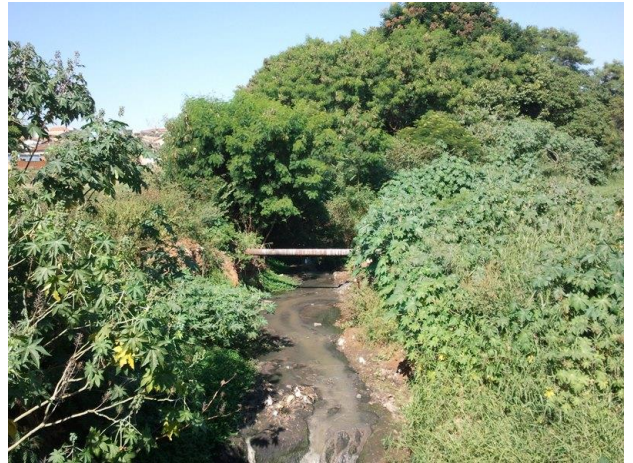
Foto 06: Vista do leito assoreado do córrego
