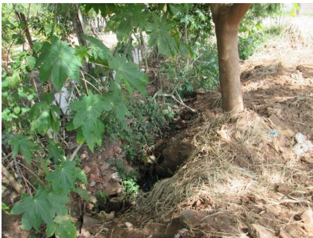
Foto 05: Detalhe da drenagem.
