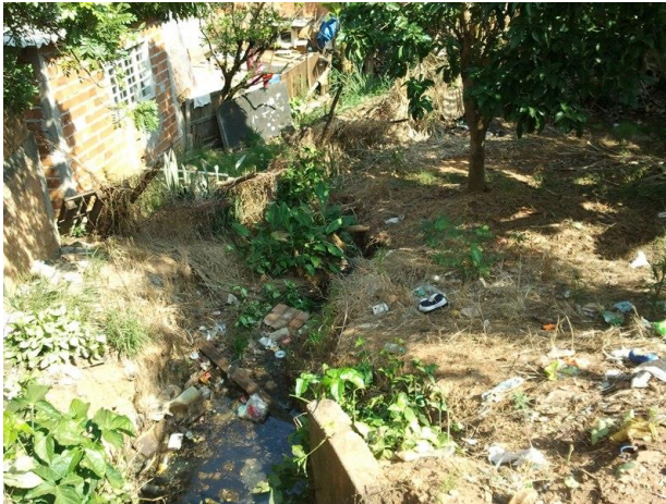
Foto 11: Detalhe da drenagem urbana.
