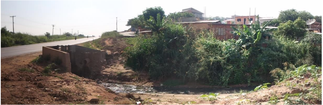
Foto 01: Vista geral do canal, assoreamento do córrego, falta de vegetação ciliar nesse trecho.
