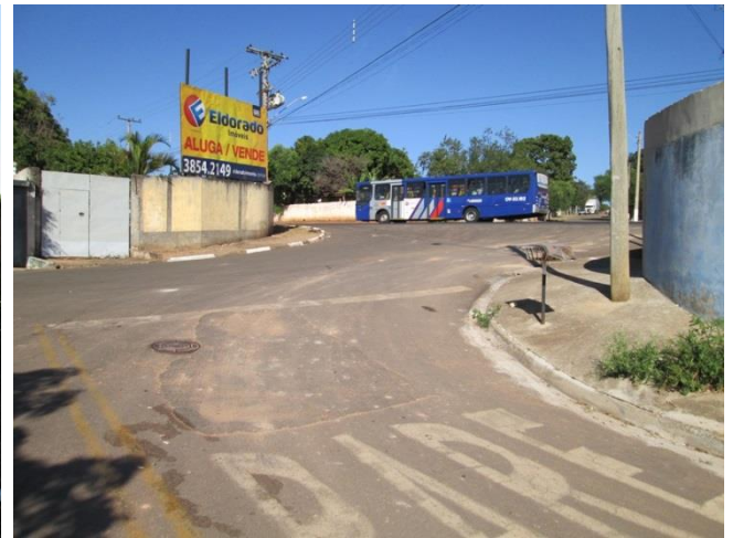
Foto 02: Vista da parte de cima da rua, sentido montante do fluxo de água que desce a vertente em direção à área de inundação do Ribeirão Quilombo.
