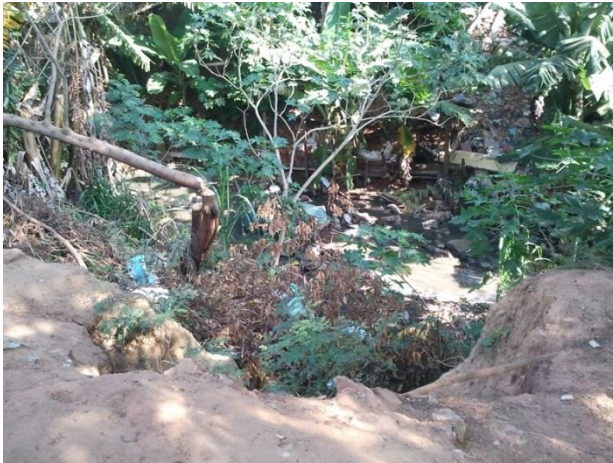
Foto 03: Erosão marginal no córrego.
