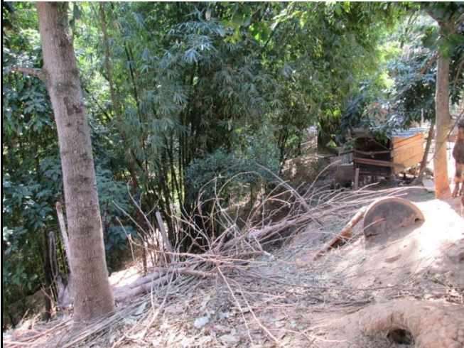
Foto 03: Margem esquerda vista da montante do córrego
