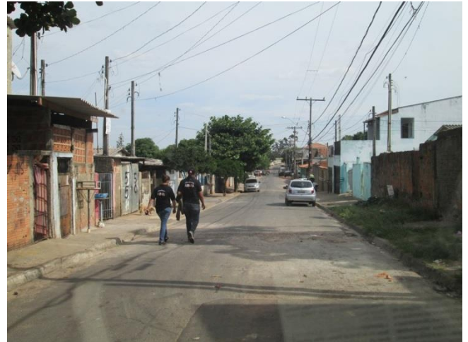
Foto 04: Vista da Rua Ismael Garbellini à esquerda as casas que margeiam o córrego em situação de risco.
