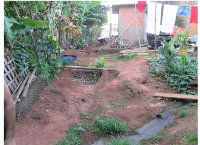
Foto 04: Terreno abaixo da rua evidencia-se sulcos erosivos.
