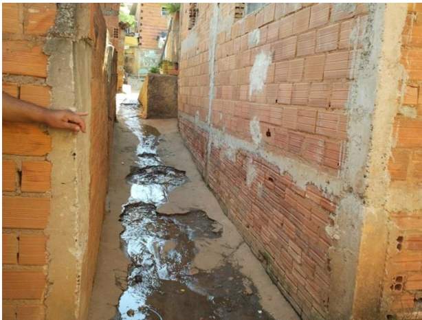
Foto 05: Água servida da parte superior da invasão, escoada até o córrego.
